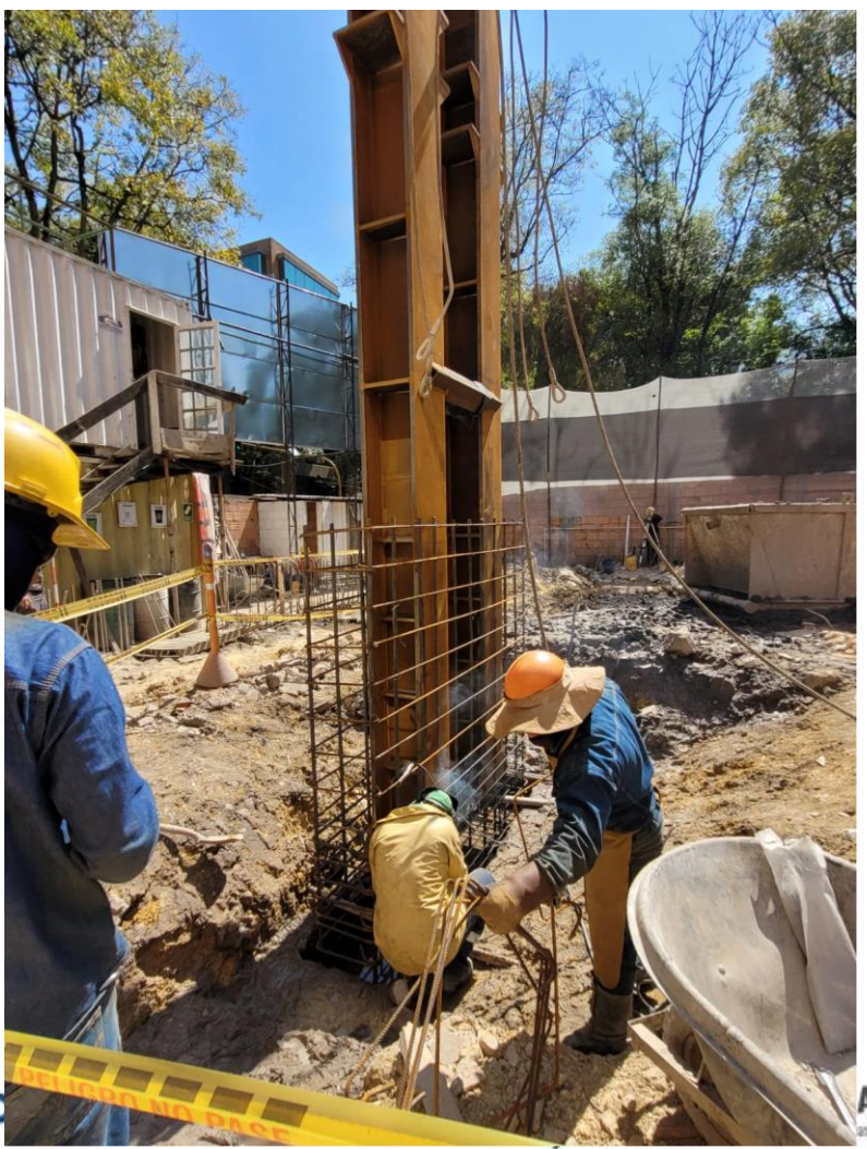
Ejecutado sobre barrete
