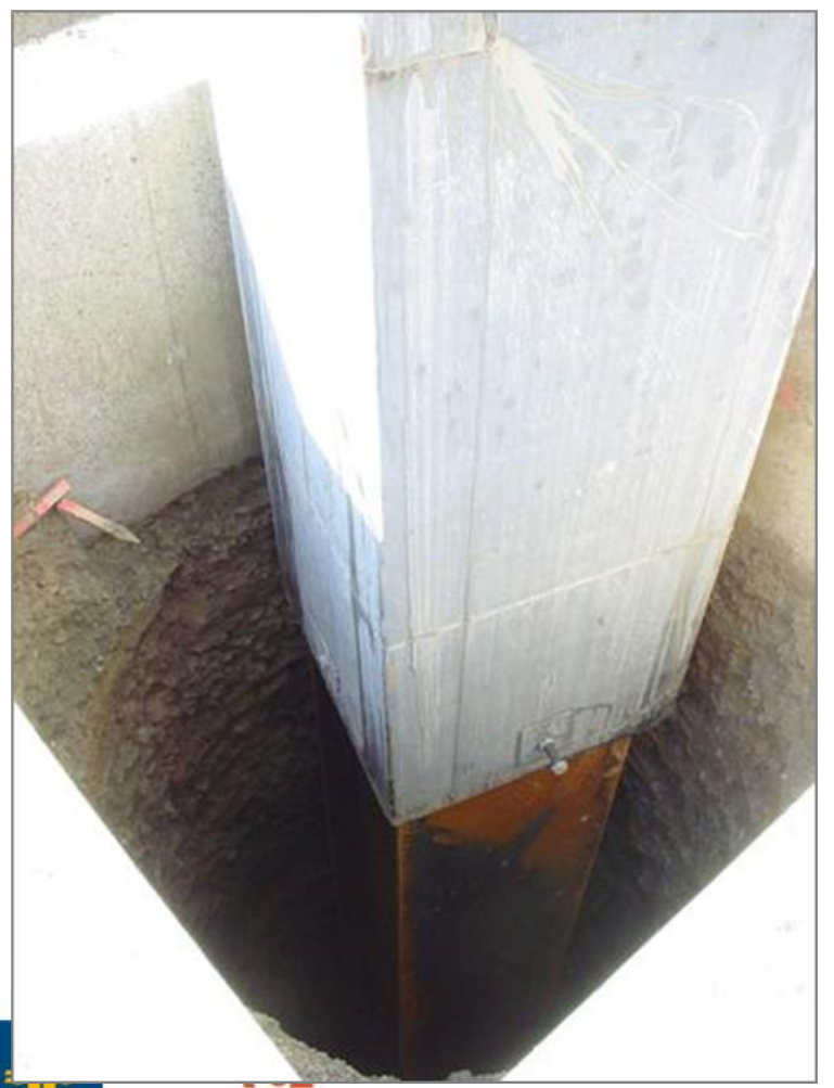
Ejecutado sobre pilote
