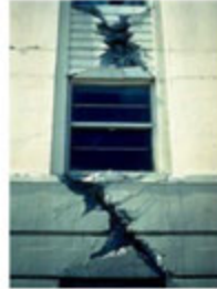
Figura 4.4.3 B Vista y acercamiento de daños con falla en X de vigas de acoplamiento en muros de cortante
