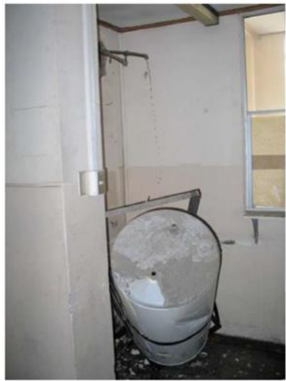
Fig. 8. Daño por agua en el Hospital Talca, sismo de Chile 2010, causado por fugas de calentadores de agua volteados. El hospital tuvo que ser cerrado por daño causado por el agua (FEMA 74, 2012).
