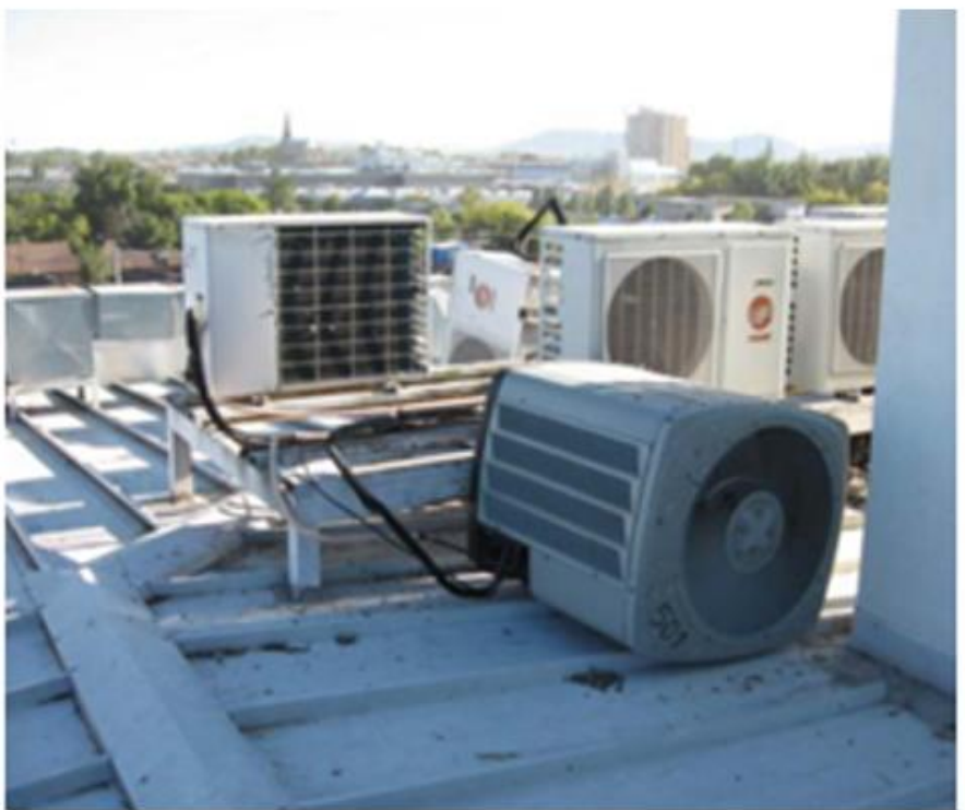
Fig. 7. Volteo de unidades de aire acondicionado en el techo de edificios, durante sismo de Chile 2010 (FEMA 74, 2012 y Miranda, 2010)
