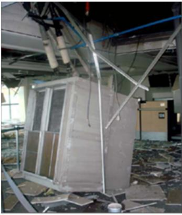
Fig. 3. Caída de equipo pesado de aire acondicionado suspendido aeropuerto de Santiago, sismo de Chile 2010 (Miranda, 2010) y colapso de techo falso, tuberías de agua, artefactos de iluminación y ductos aire acondicionado suspendidos, aeropuerto de Santiago, sismo de Chile 2010 (Miranda 2010, EERI 2010)
