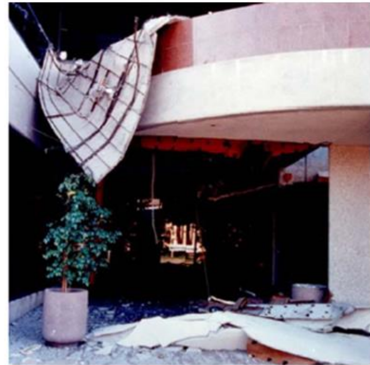
Fig. 2. Caída tuberías colgadas edificio en Bucaramanga, sismo 2015 (Vanguardia.com) y caída torta inferior entrada a un edificio, sismo de Northridge 1994 (FEMA 74, 2012).
