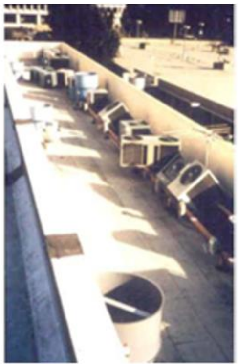
Fig. 7. Volteo de unidades de aire acondicionado en el techo de edificios, durante sismo de Chile 2010 (FEMA 74, 2012 y Miranda, 2010)
