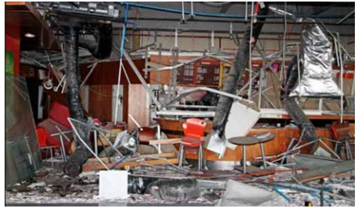
Fig. 3. Caída de equipo pesado de aire acondicionado suspendido aeropuerto de Santiago, sismo de Chile 2010 (Miranda, 2010) y colapso de techo falso, tuberías de agua, artefactos de iluminación y ductos aire acondicionado suspendidos, aeropuerto de Santiago, sismo de Chile 2010 (Miranda 2010, EERI 2010)
