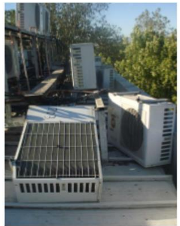
Fig. 7. Volteo de unidades de aire acondicionado en el techo de edificios, durante sismo de Chile 2010 (FEMA 74, 2012 y Miranda, 2010)
