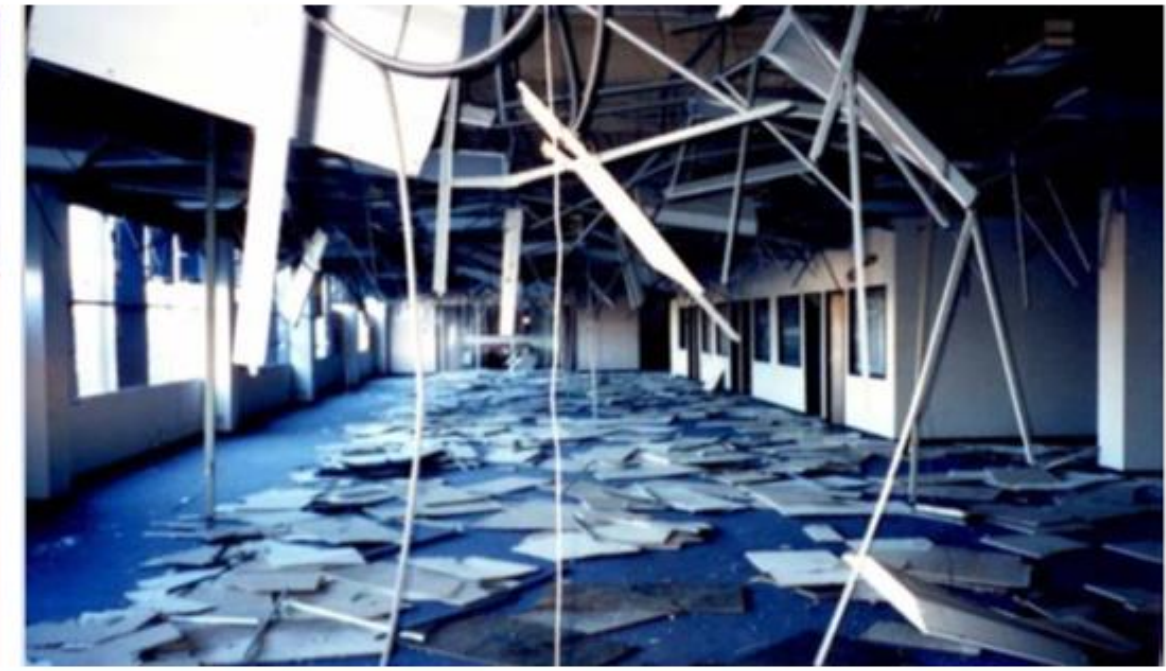
Fig. 1. Falla de particiones, techos falsos y artefactos de iluminación en el sismo de Northridge de 1994 (FEMA 74, 2012)
