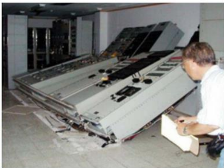
Fig. 9. Daño a equipo de cómputo, eléctrico y comunicaciones, anclaje inadecuado o colapso pisos falsos (FEMA 74, 2012)
