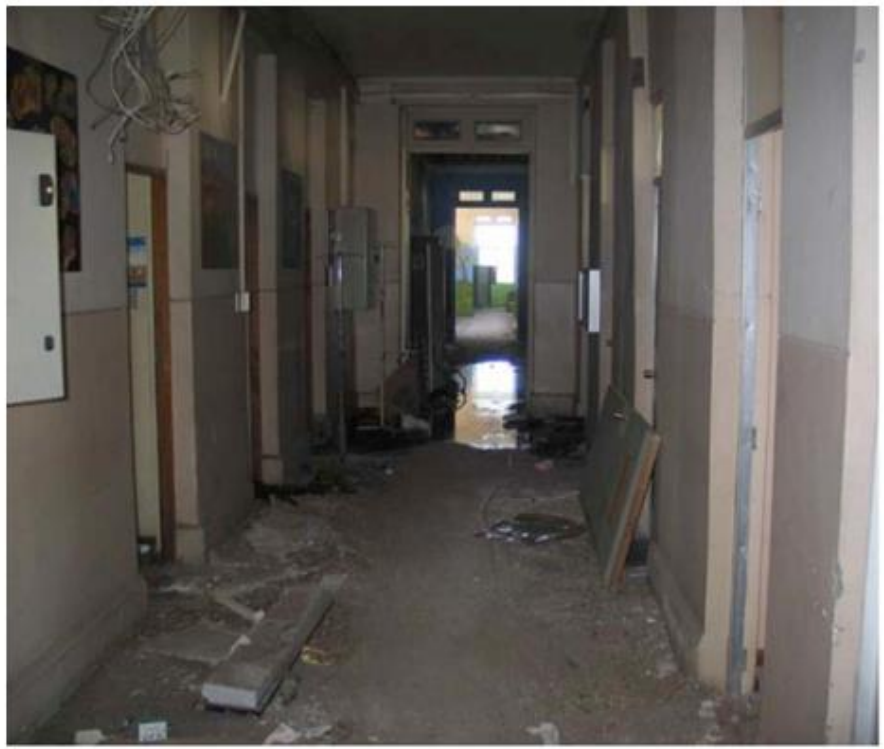
Fig. 8. Daño por agua en el Hospital Talca, sismo de Chile 2010, causado por fugas de calentadores de agua volteados. El hospital tuvo que ser cerrado por daño causado por el agua (FEMA 74, 2012).
