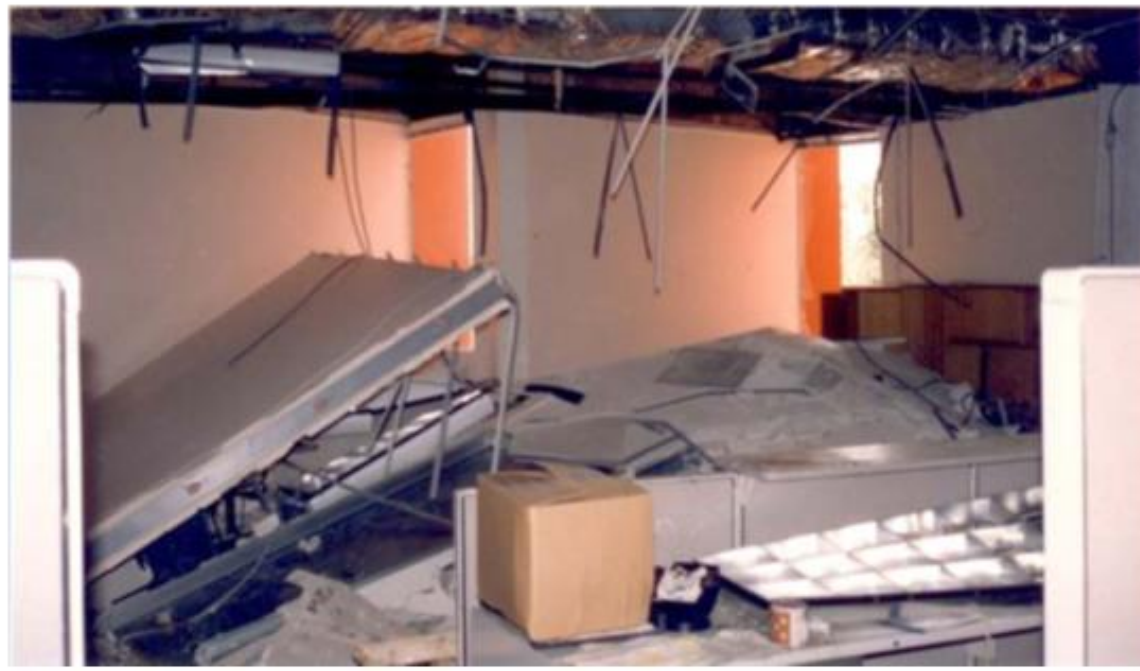
Fig. 1. Falla de particiones, techos falsos y artefactos de iluminación en el sismo de Northridge de 1994 (FEMA 74, 2012)
