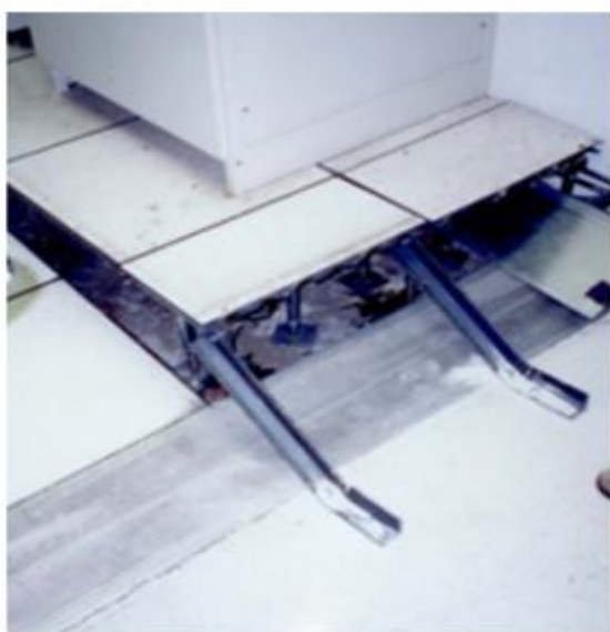
Fig. 9. Daño a equipo de cómputo, eléctrico y comunicaciones, anclaje inadecuado o colapso pisos falsos (FEMA 74, 2012)
