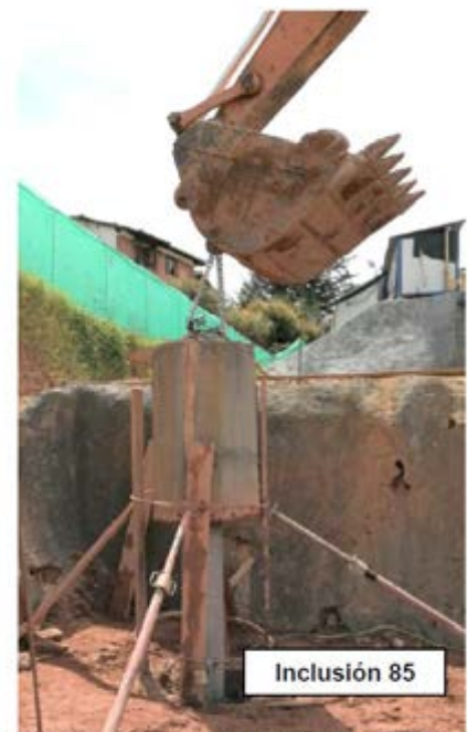
Sistema de impacto compuesto por una masa de 1.5 Ton soltada en caída libre.
