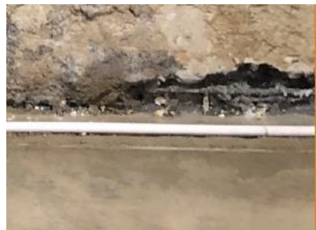
Retirar y reparar la corrosión en acero (Si se presenta)
