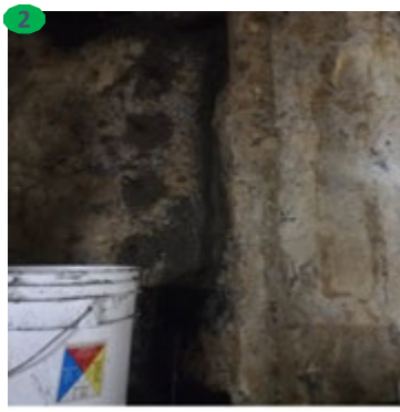
Colocación de puertos y confinamiento De grieta
