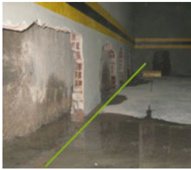
Tapar el muro y conducir el agua... "Muro aparente" o "Muro de limpieza"
