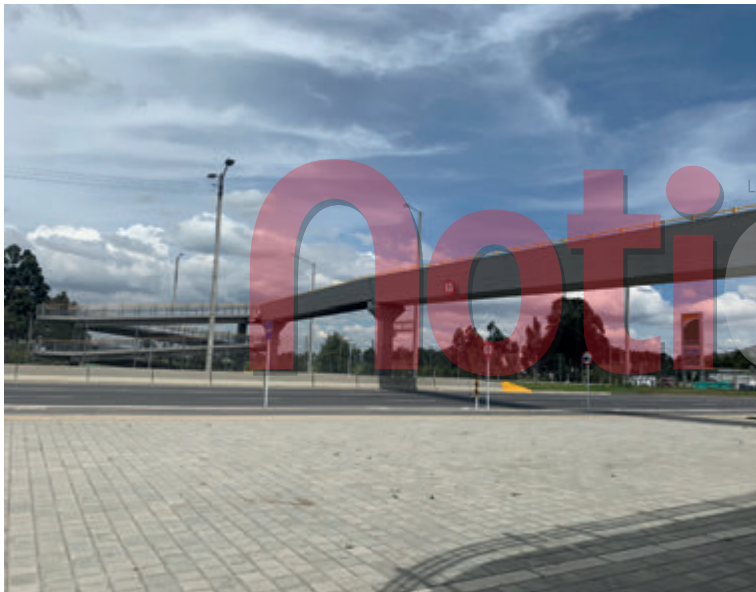
↑ Foto 3. Prefabricados para puentes peatonales.
